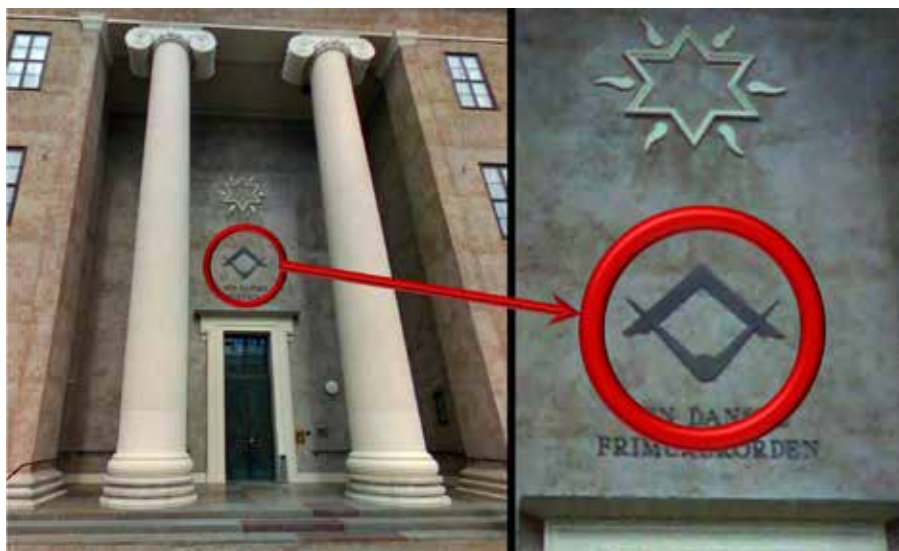
Passer og vinkel på DDFO's bygning 2014
